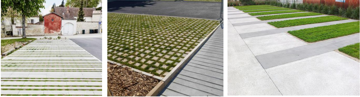
Exemple de sol permettant l'infiltration d'eau
