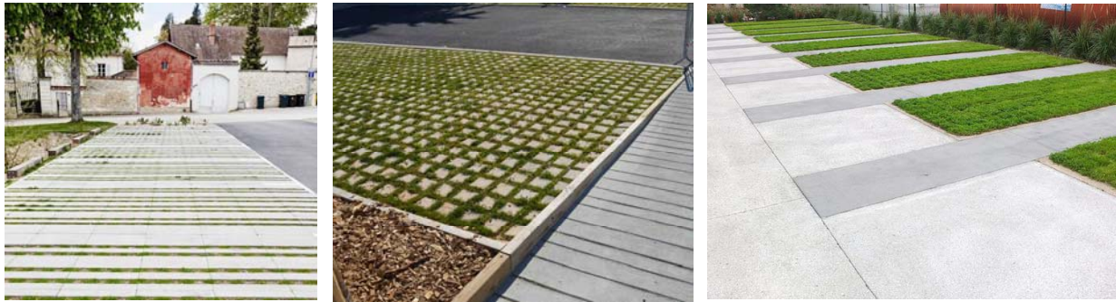
Exemple de sol permettant l'infiltration d'eau
