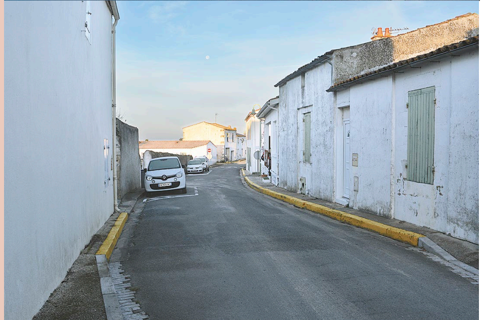
Un investissement important dédié à cette réfection de voirie
