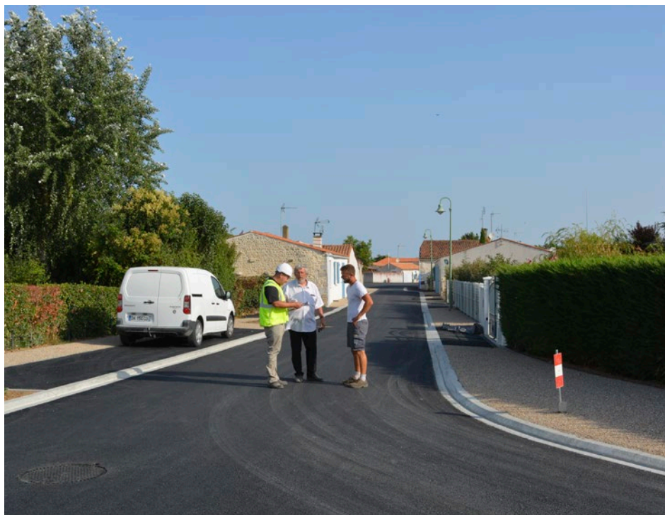
La dernière réunion de chantier a eu lieu le 23 juillet
