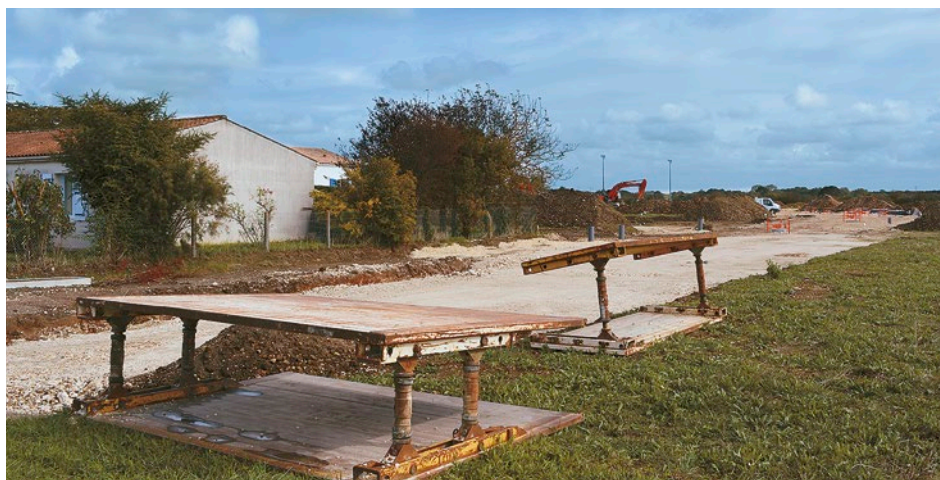
Les engins s'activent sur le chantier pour respecter les délais
