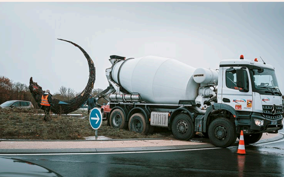
Coulage du ciment sur le coffrage
