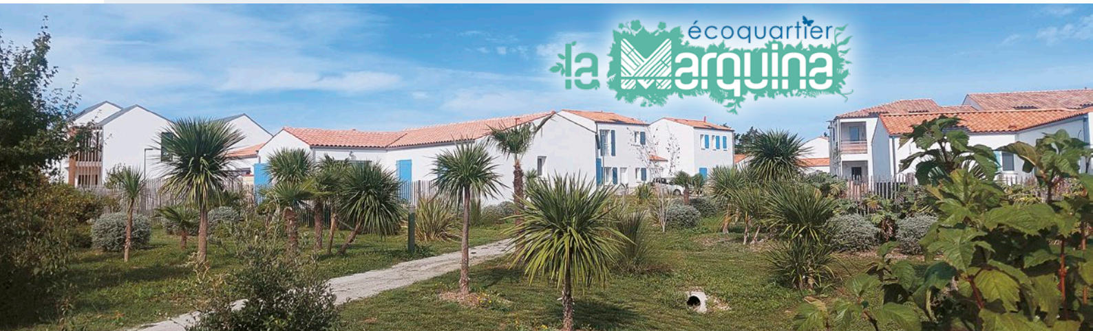
Des accès cheminent pour relier les habitations au parc
