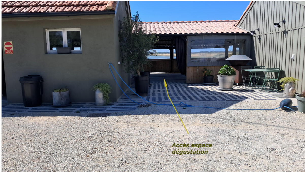
Accès à l'espace dégustation et au WC PMR
