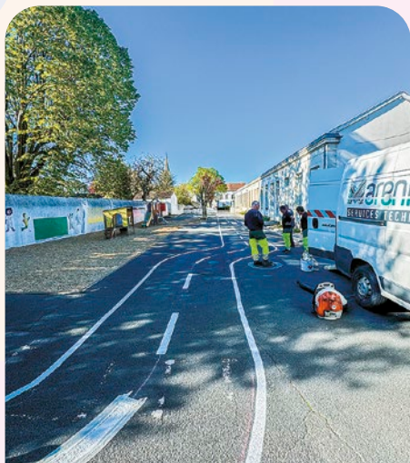
Peinture en cours par les services techniques
