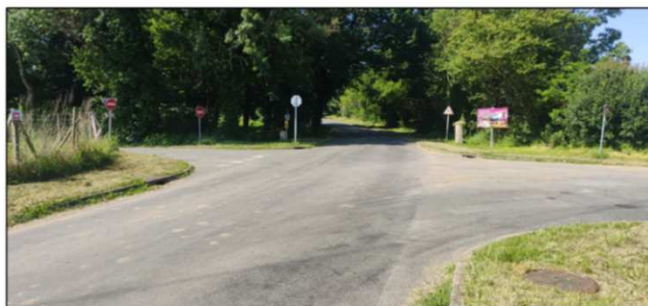
Carrefour rue des Bois/rue de la Gateaudière, le 4 juin 2024
