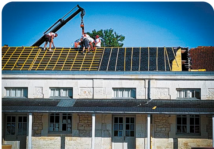
Travaux importants sur la toiture de l'école Henry Aubin
